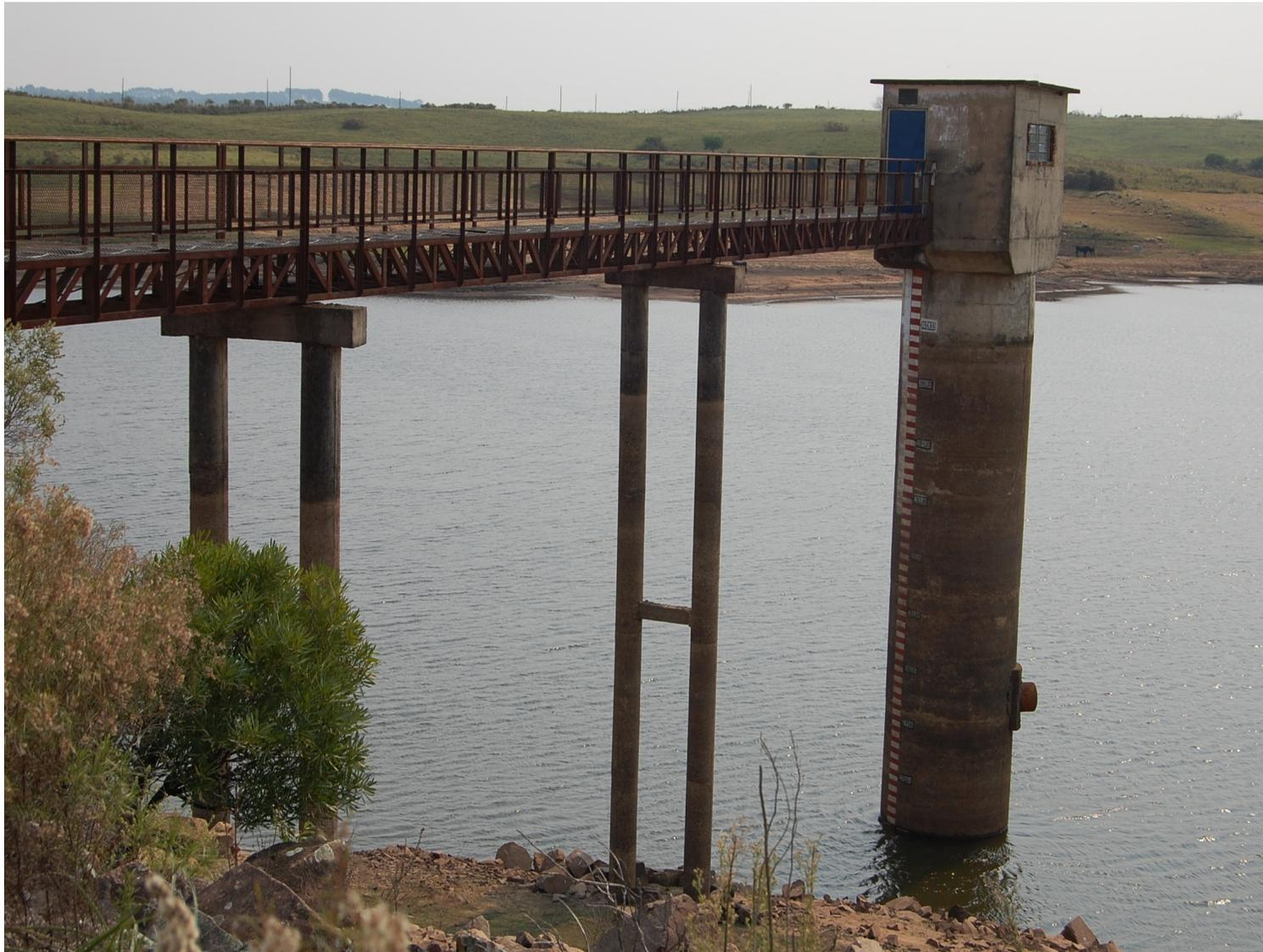
**Destaque para a régua de medição de nível de água – Barragem de Piray – Bagé**
